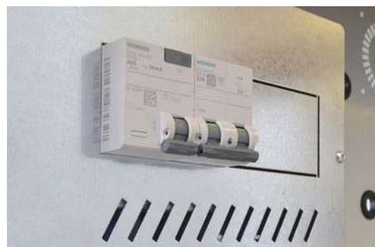
Limitador y magnetotérmico
