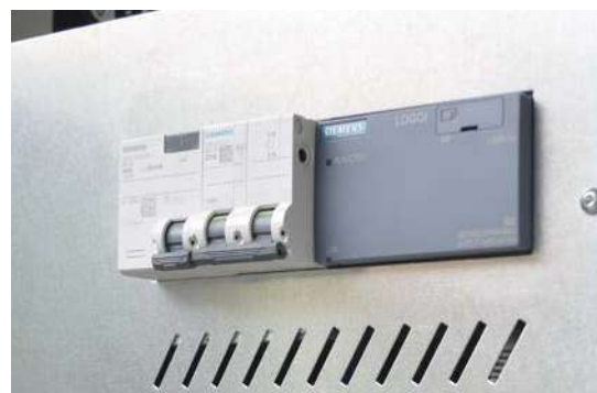
Limitador, magnetotérmico y automático
